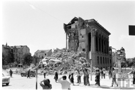
Sl. 4. Oštećenje objekta nakon potresa
